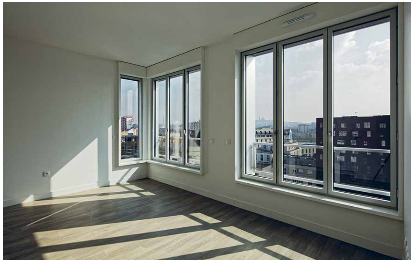
Le coffre des volets roulants est associé au cadre des fenêtres; les vues sur le paysage urbain sont mises en scène.
