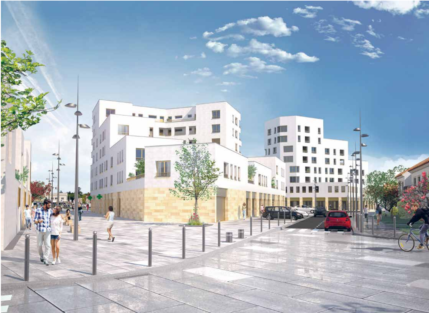
Les bâtiments étagés ou en gradins permettent de cohabiter avec la petite échelle du tissu existant.
