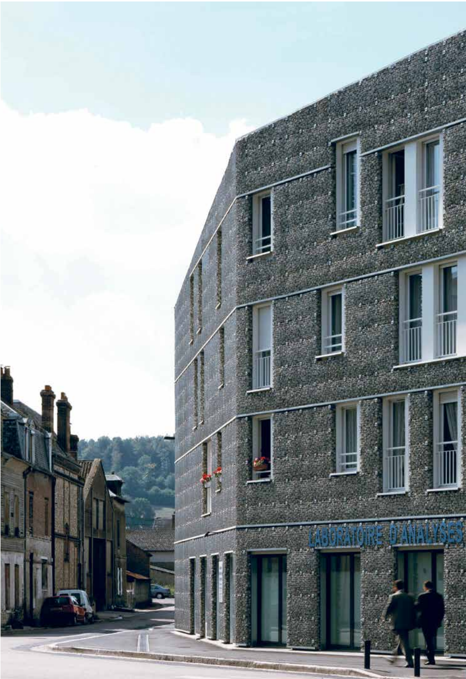
Le bâtiment neuf habillé de galets se mesure aux petites architectures traditionnelles normandes.
