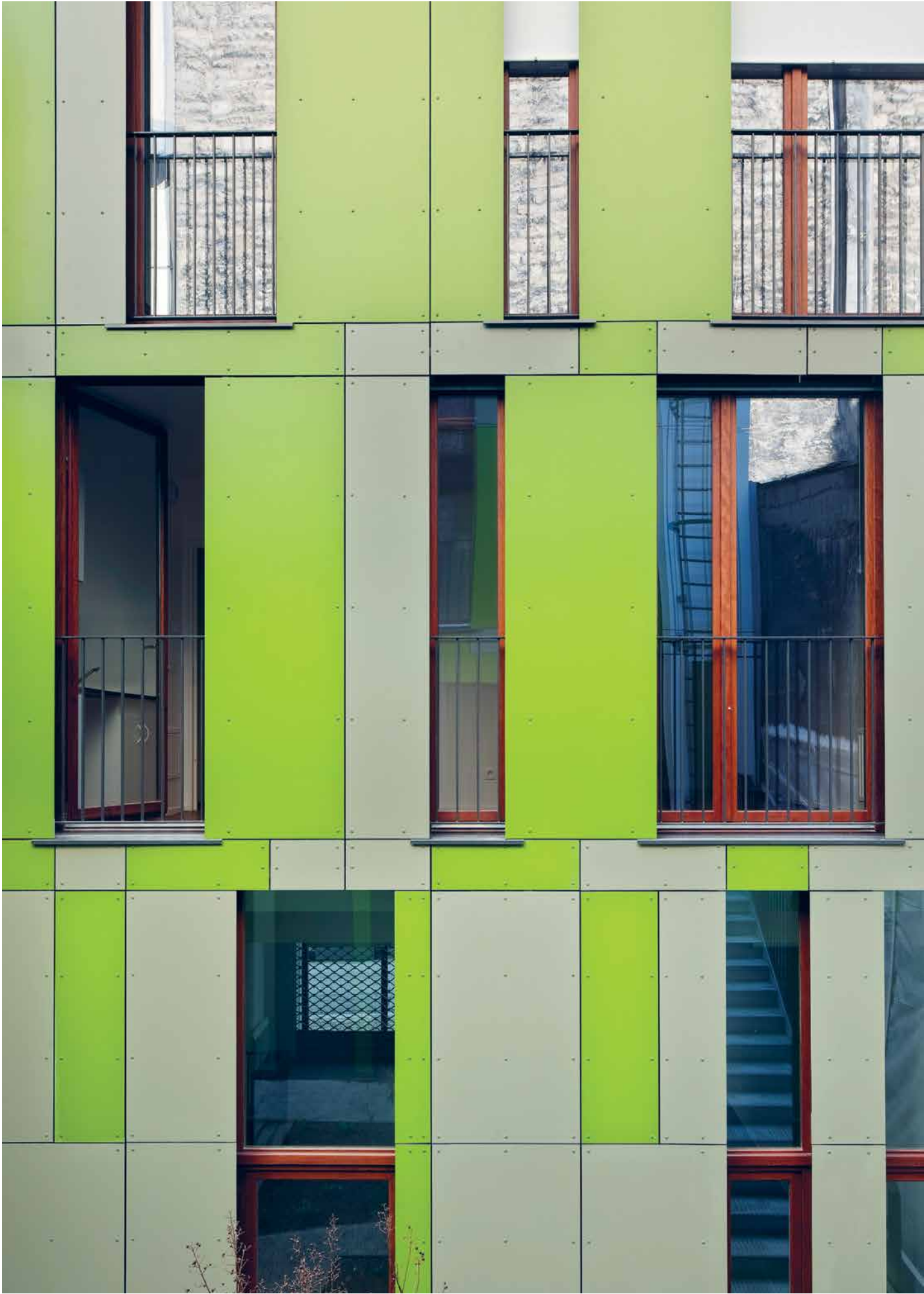
La façade jardin est une marqueterie colorée qui encadre le jardin intérieur.
