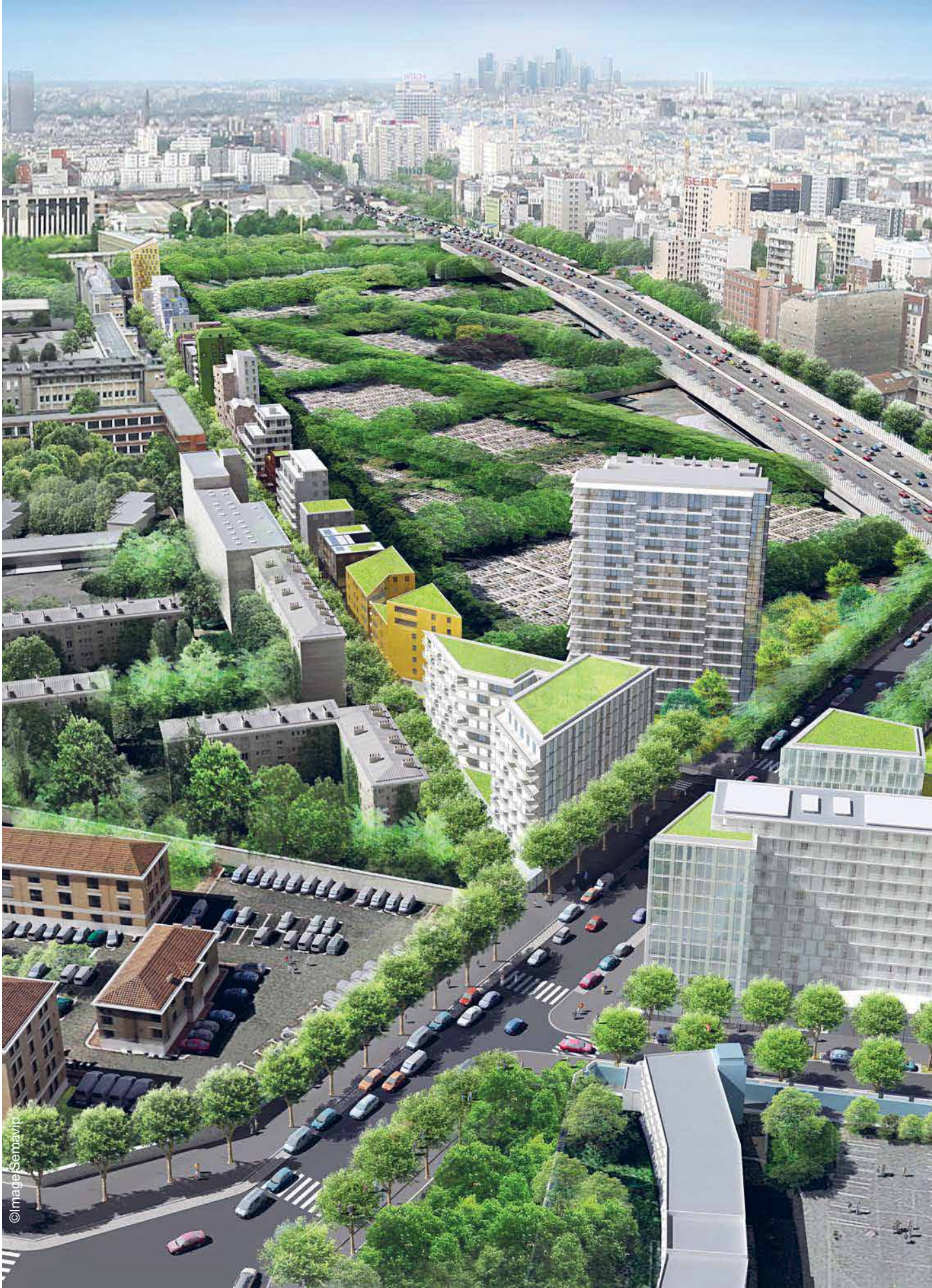
La rue Rebière réinventée accueille 160 logements sociaux, 55 logements en accession, une crèche de 60 berceaux, un square de proximité et des locaux associatifs. Les architectes Lacaton, Vassal et Druot donnent une seconde vie à la tour Bois-le-Prêtre métamorphosée.
