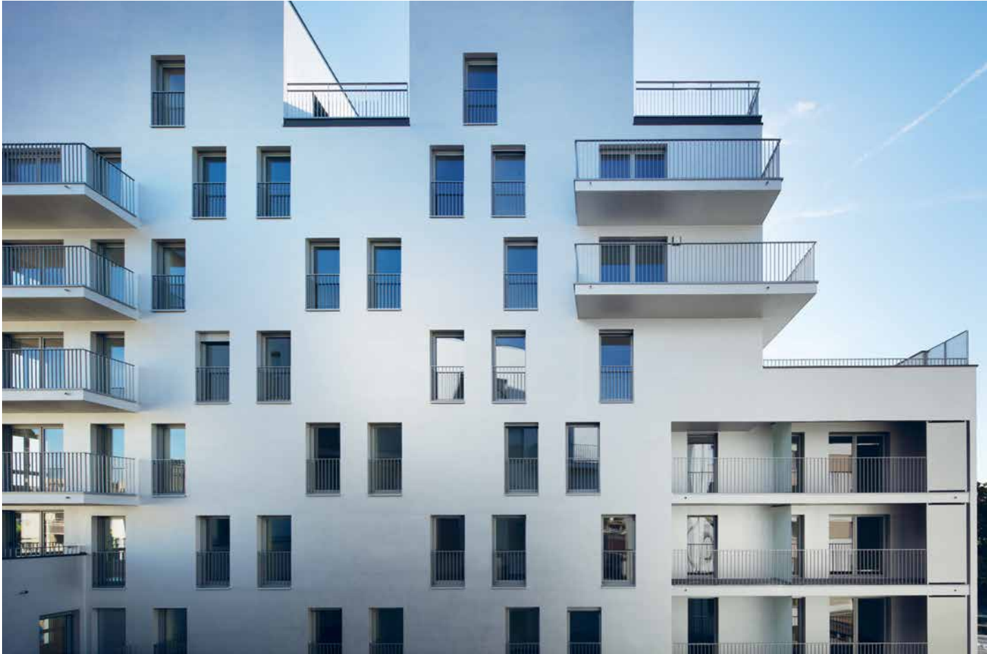
Le revêtement métallisé des façades intérieures capte la lumière du sud. La couleur sombre de la façade côté place, orientée plein nord, est atténuée par l'ordonnement régulier des grandes fenêtres.
