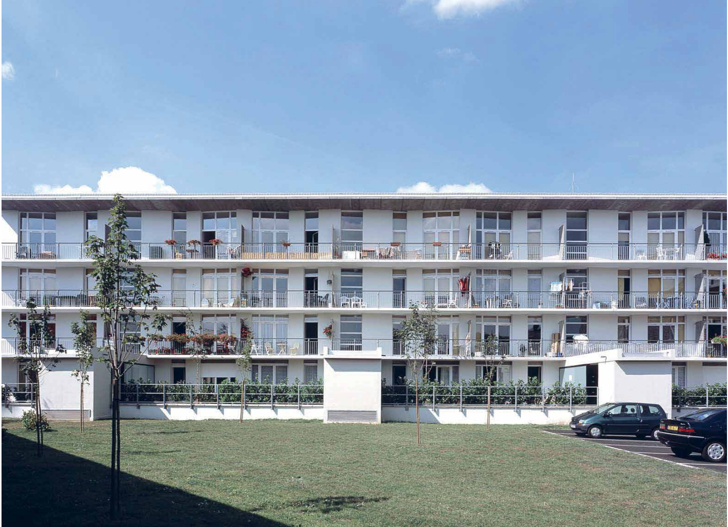
Les grands balcons filants de la façade jardin constituent également l'indispensable protection solaire d'une exposition plein sud.
