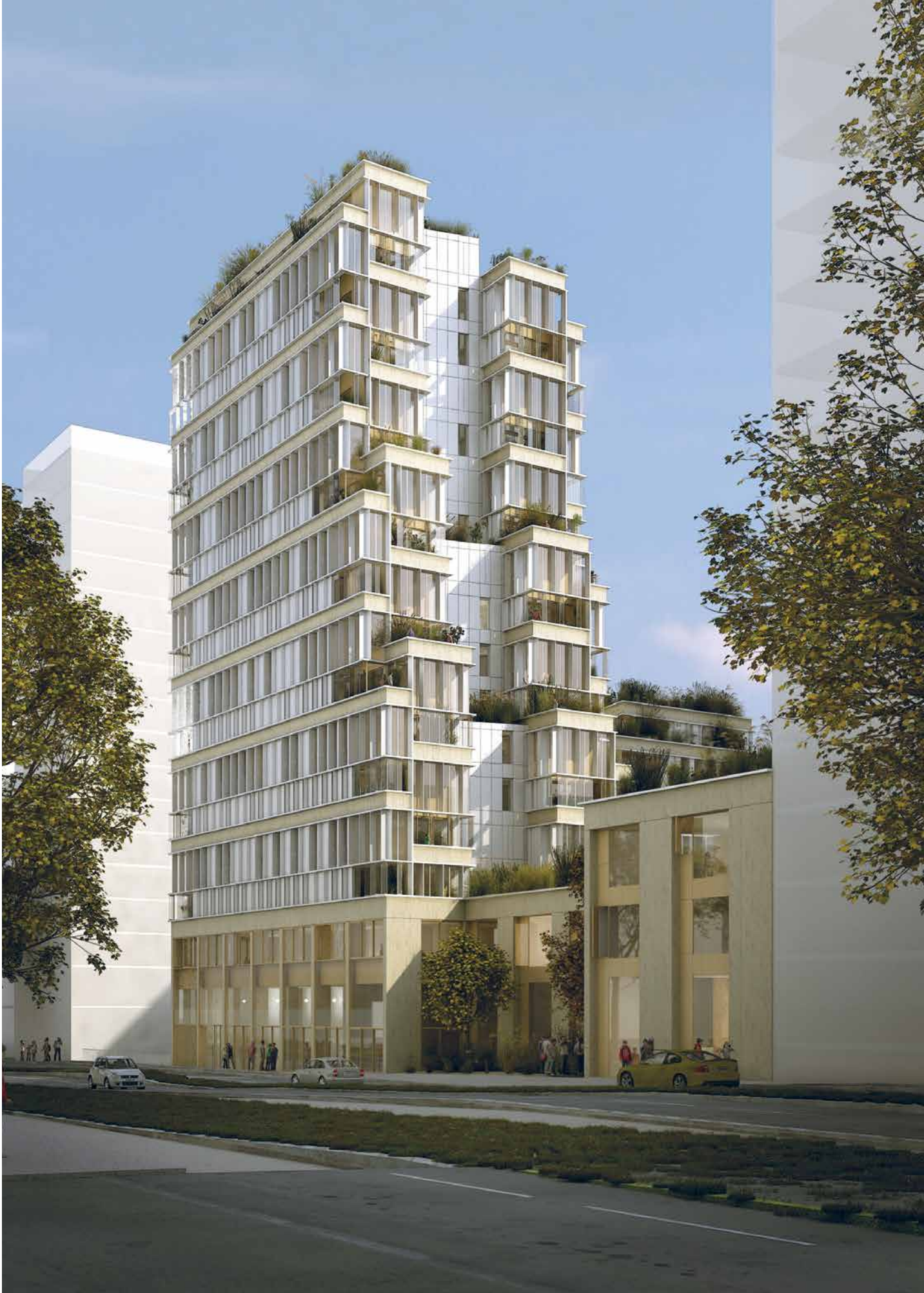
Les loggias double hauteur disposées en quinconce accompagnent une architecture en gradins qui atténue les effets de grande hauteur.
