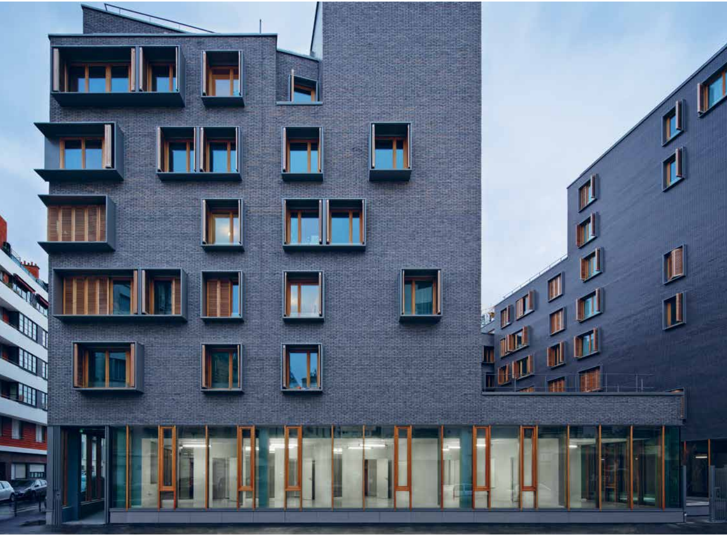
Les grands ensembles menuisés des séjours d'angle créent le motif particulier attendu par l'urbaniste de la ZAC, Paul Chemetov.
