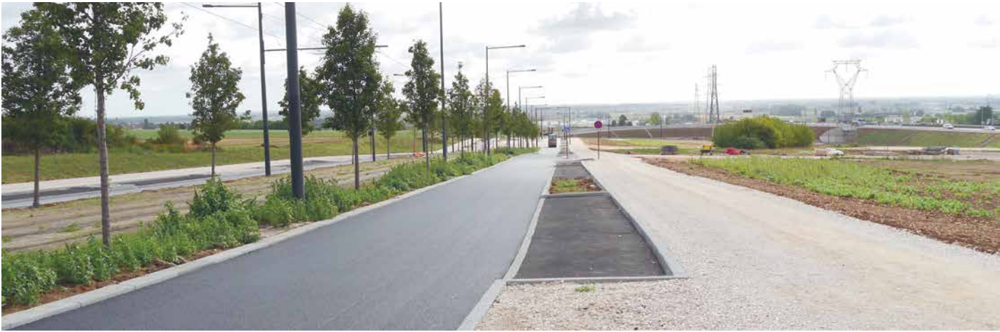
Le chantier du boulevard et du tram préfigure la qualité du futur quartier.
