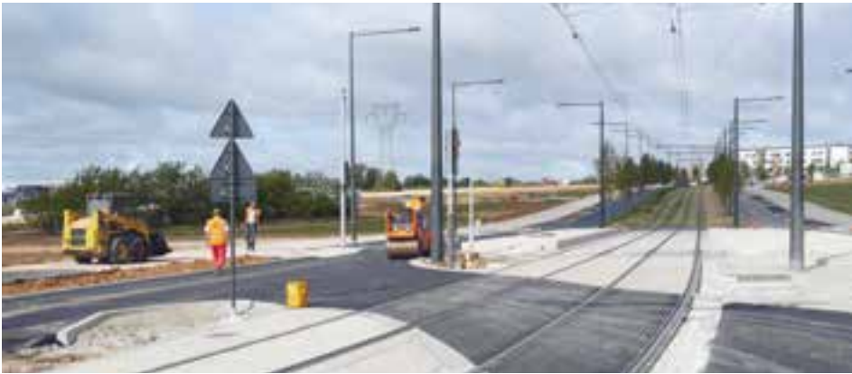
▲ Chantier autour de la future station de tramway
