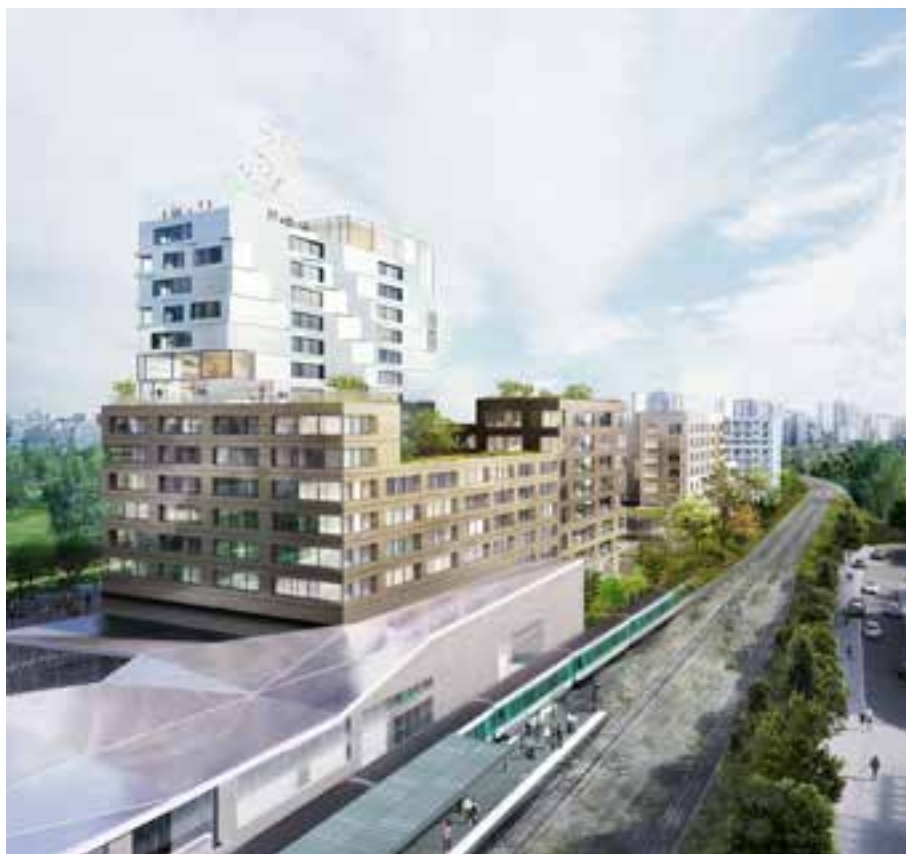
▲ L'ensemble accompagne les voies du métro aérien
