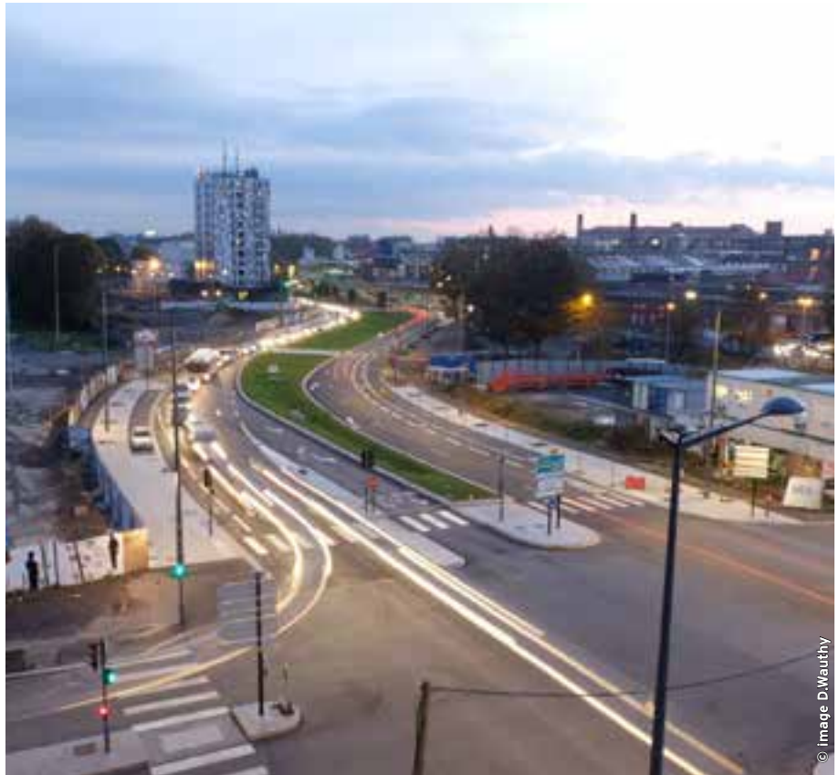
▲ Le boulevard Belfort et la Tour Clémenceau
